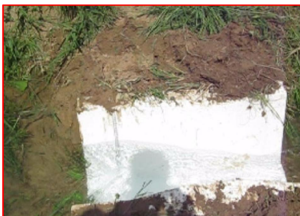
شکل ۳- نصب و تراز در جهات مختلف WSC فلوم اندازه‌گیری دبی
