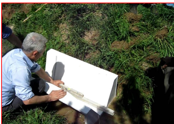
شکل ۳- نصب و تراز در جهات مختلف WSC فلوم اندازه‌گیری دبی
