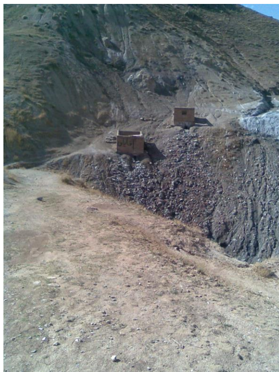
تصویر ۲- دورنمایی از چشمه آبگرم و اتاقک‌های موجود
