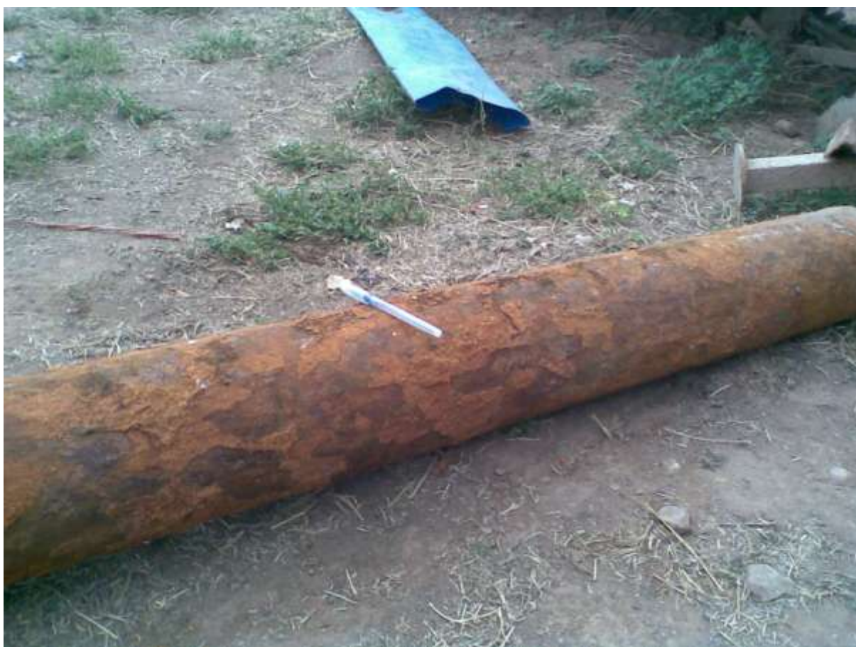
شکل ۴ - ۱: تصویری از لوله جدار چاه مخروبه آقای مرزبان ( شمال شرق روستای یوشانلو- حاشیه جاده سلماس - تسوج ۸۷/۶/۹)
