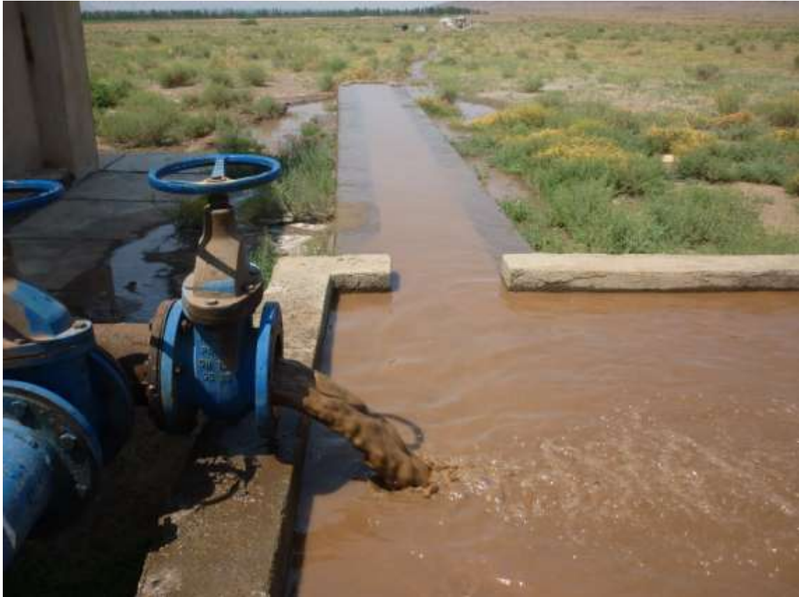
شکل ۴-۲: تصویری از چاه شماره 2 جهاد امور عشایر سلماس - دشت چوپانلو ( غرب روستای چوپانلو - ( ۸۸/۵/۱۴
