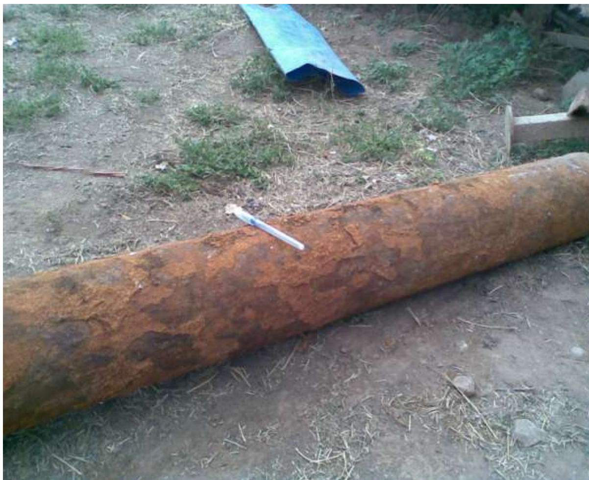
شکل ۲ - ۱: پدیده خوردگی در لوله جدار چاه آب منطقه مطالعاتی (چاه عباس مرزبان - ۸۷/۵/۱۲)
