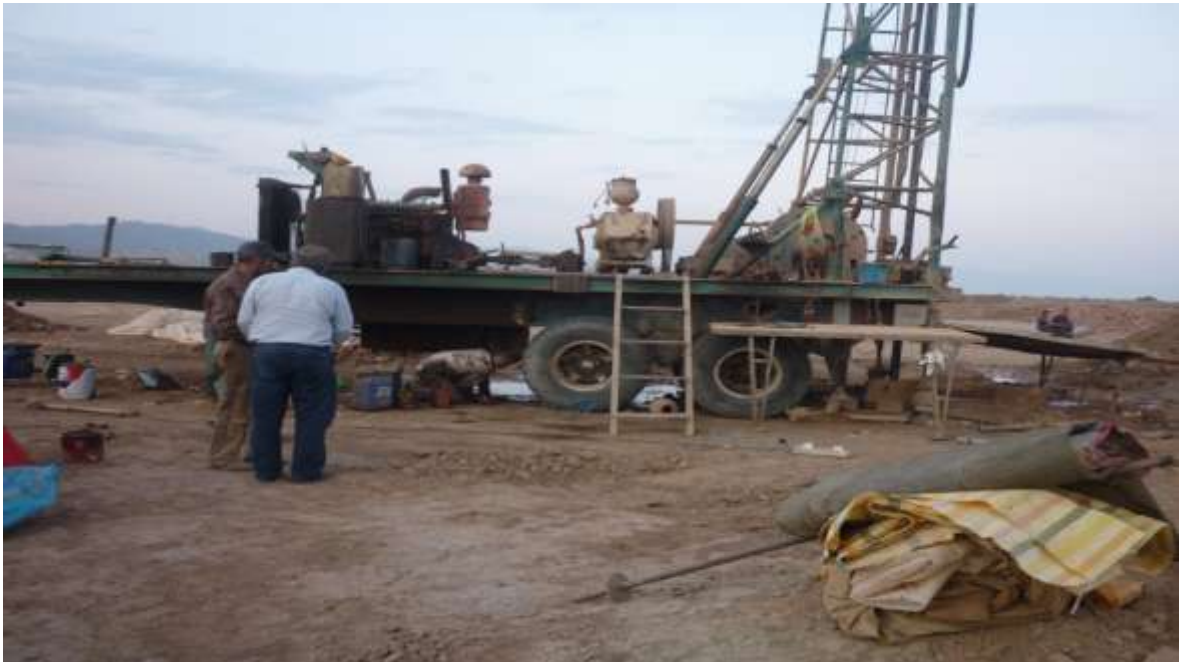
شکل ۵- ۱۹: تصاویر مربوط به چاه جدید الحفر و سنگ کف، شمال شرق منطقه- حاشیه جاده سلماس - تسوج (۸۸/۶/۹)
